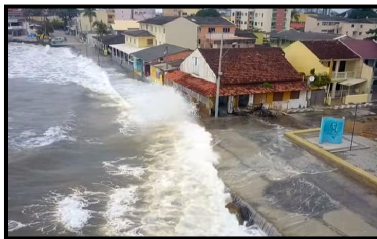
Figura 46. Fortye maré alta e erosão costeira em Matinhos-Pr (2019) (fonte: https://tribunapr.uol.com.br/wp-content/uploads/sites/1/2019/07/ressaca-matinhos.jpg )
