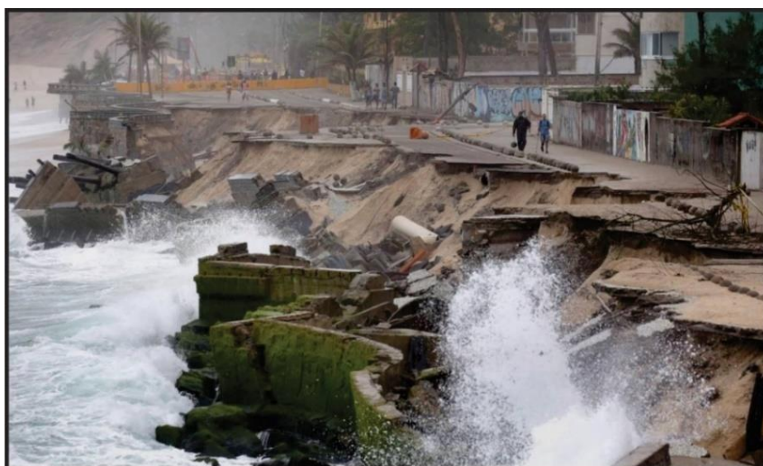
Figura 48. Força das ondas causou desmoronamento do calçadão na orla da Praia da Macumba, no Recreio dos Bandeirantes – RJ (fonte: Marcio Alves/Agência O Globo)
