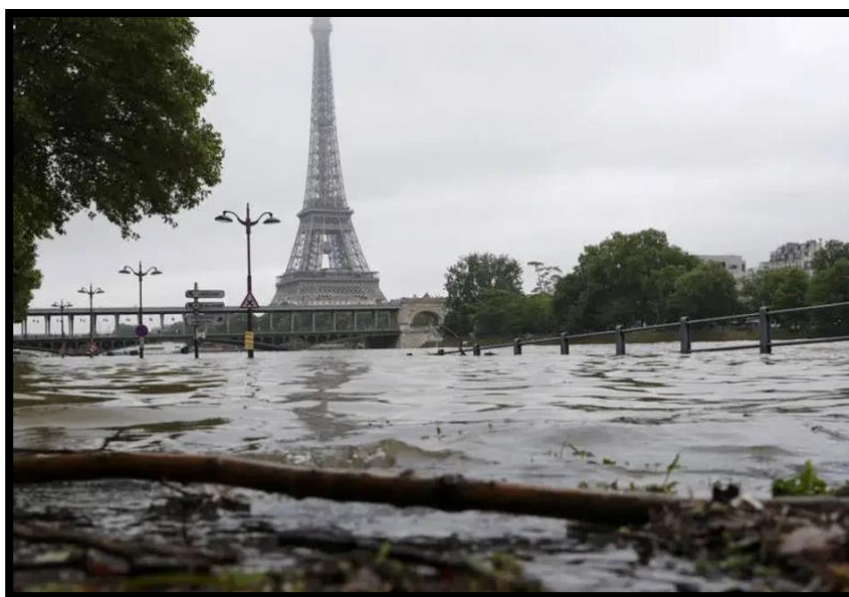
Figura 50. Enchente em Paris em 2018, devido a elevação de mais de 6 m do rio Sena. (foto: https://classic.exame.com/wp-content/uploads/2016/09/size_960_16_9_paris-enchentes1.jpg )
