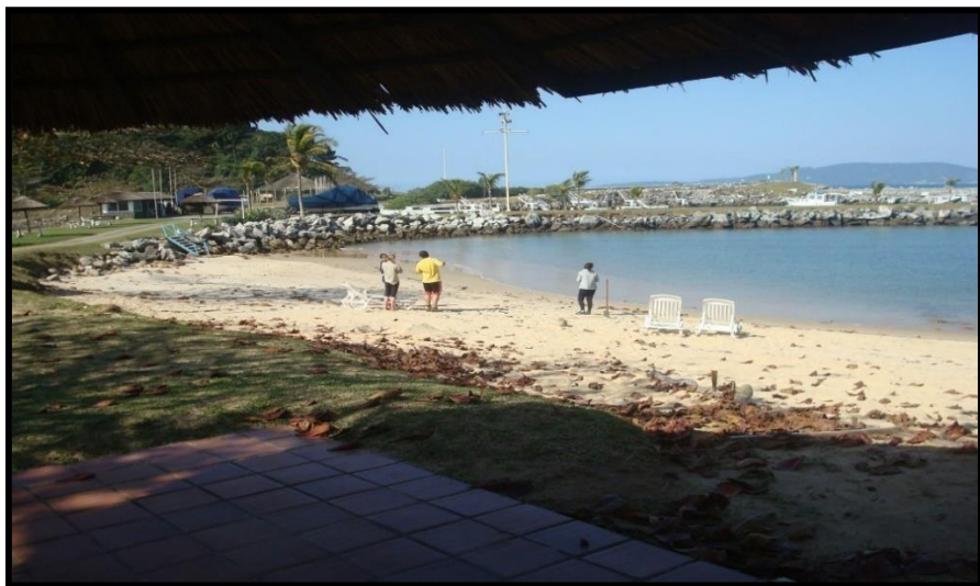
Foto 149 . Vista para nordeste da praia da Marina Plaza, no município de Itapema, observando-se a estrutura rígida do molhes (Foto de Norberto Olmiro Horn Filho, 26/7/2011).
