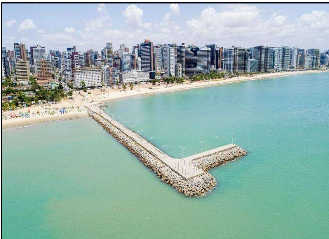
Figura 21. Estrutura de espigão implantada na praia de Iracema em Fortaleza - CE.
