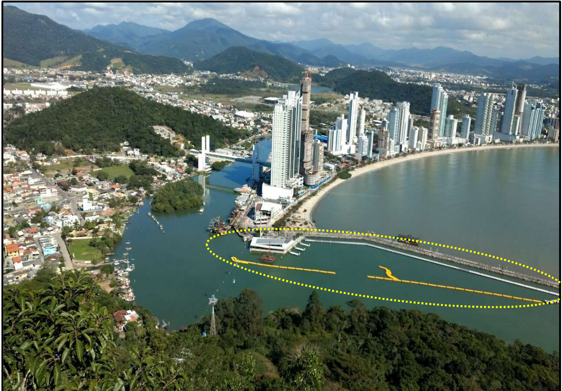
Vista para norte da doca (estrutura #86) implantada na praia do Balneário Camboriú Sul, no município de Balneário Camboriú, litoral Centro-norte de Santa Catarina. Fonte: (Thati Iagui).
