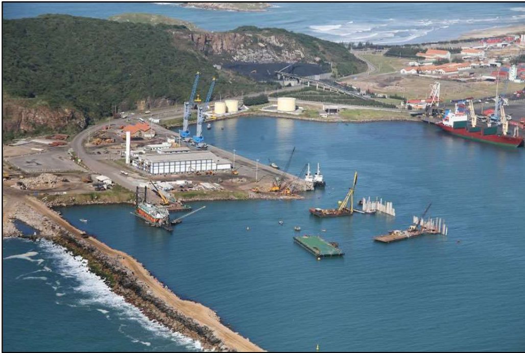
Figura 59. Vista do enrocamento (#10) do Porto de Imbituba localizado na praia do Porto Sul, no município de Imbituba.
