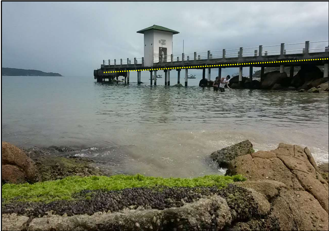
Vista para norte do píer (estrutura #52) (trapiche da praia de Bombinhas) implantado na praia da Lagoinha, no município de Bombinhas, litoral Centro-norte de Santa Catarina. Fonte: (Ester Galvani).
