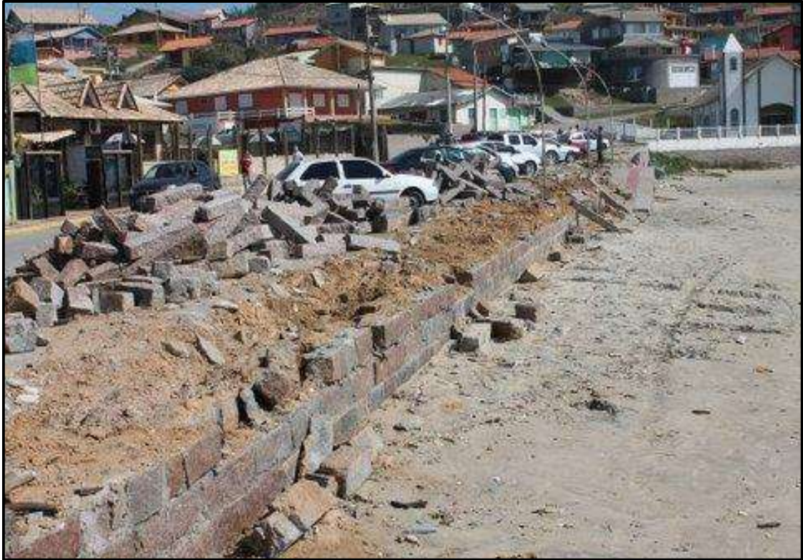
Figura 52. Estrutura tecnogênica do tipo muro (#7) danificada no ano de 2010 após sofrer ação erosiva por ocasião de ondas de tempestade na Prainha de Santa Marta, no município de Laguna.
