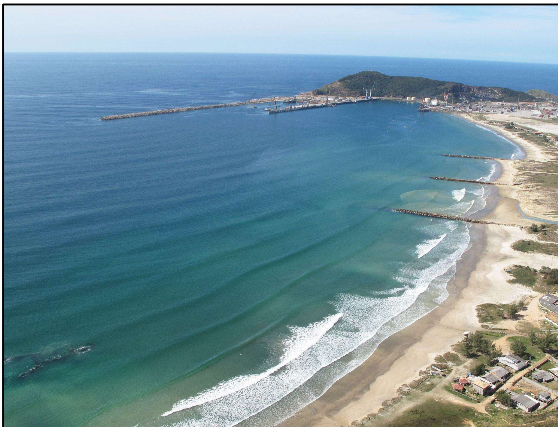
Figura 61. Vista para sul das praias do Porto Central e Porto Norte no município de Imbituba, onde são visualizadas as três estruturas rígidas do tipo espigão (#13 a #15).
