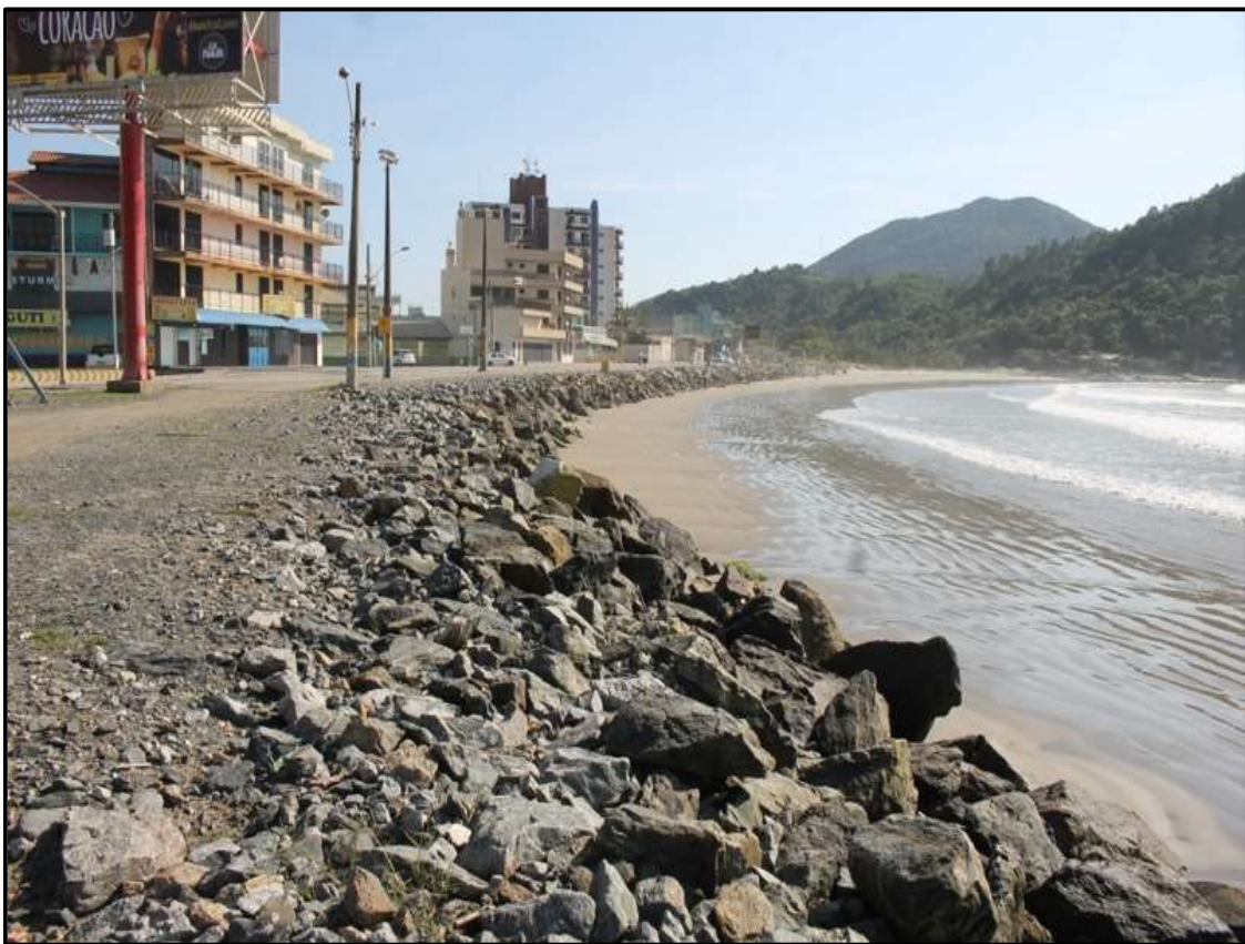
Figura 92. Vista para norte do enrocamento localizado na praia do Gravatá, no município de Navegantes.
