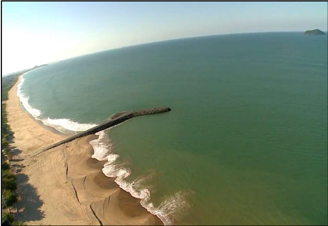
Vista para norte do espigão (estrutura #102) implantado na praia de Piçarras Central, no município de Balneário Piçarras, litoral Centro-norte de Santa Catarina.
