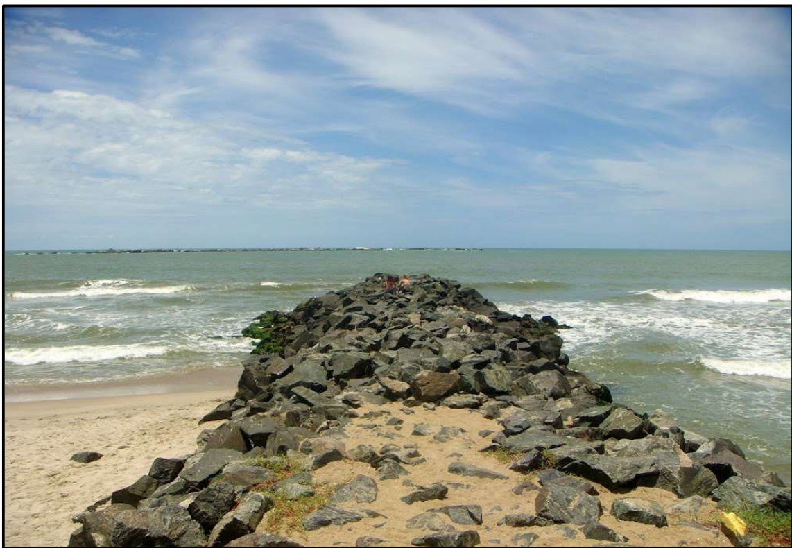
Vista para leste do espigão (estrutura #106) implantado na praia de Barra Velha Central, no município de Barra Velha, no litoral Centro-norte de Santa Catarina.
