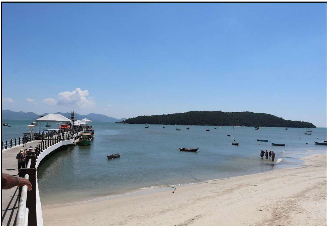
Vista para noroeste do píer (estrutura #70) (Píer Turístico Municipal de Porto Belo) implantado na praia de Porto Belo, no município de Porto Belo, litoral Centro-norte de Santa Catarina, que dá acesso hidroviário à ilha de Porto Belo ou João da Cunha.
