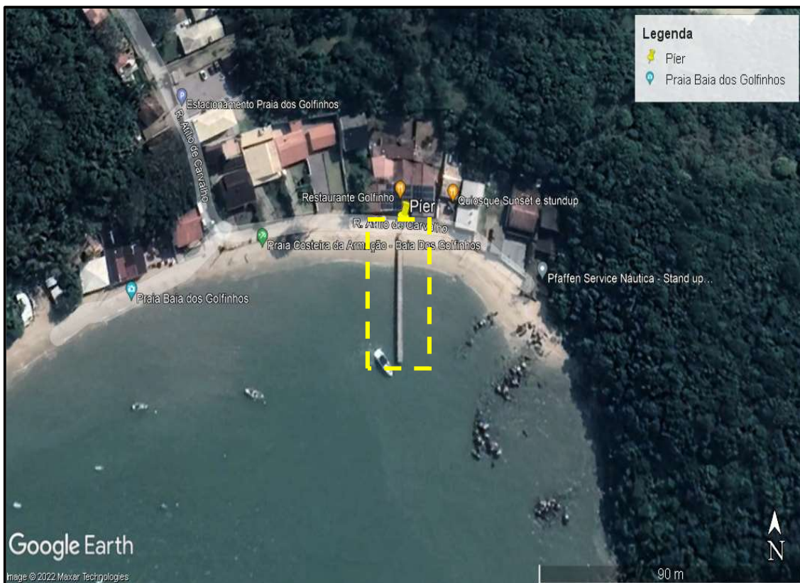
Figura 75. Estrutura tecnogênica píer (#27) na praia da Baía dos Golfinhos, no município de Governador Celso Ramos.
