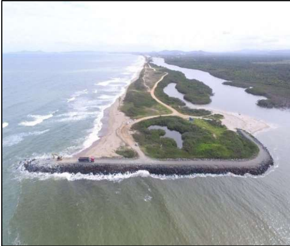
Figura 98. Vista para sul do molhe (#114) implantado na praia da Barra Velha Norte, no município de Barra Velha.
