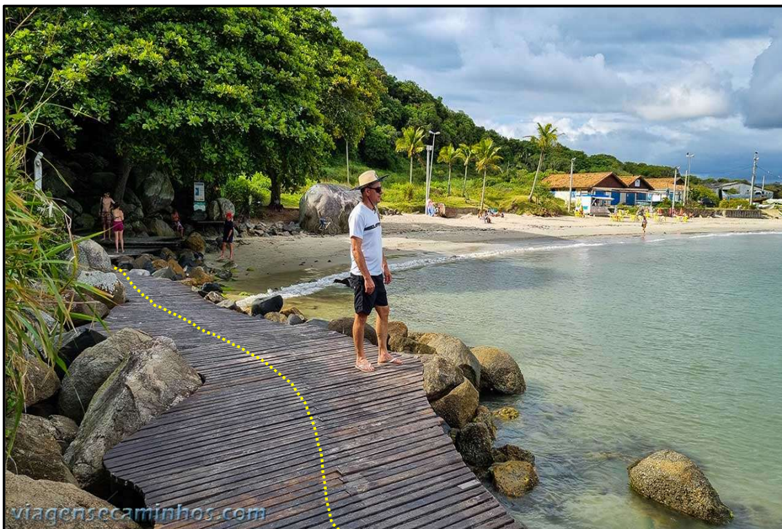
Vista para sul do píer e enrocamento (estruturas #20 e #21) implantados no canto Sul da praia dos Ingleses, no município de Florianópolis, litoral Central de Santa Catarina. Fonte: ( https://www.flickr.com/photos/dircinha/6044354186 ).
