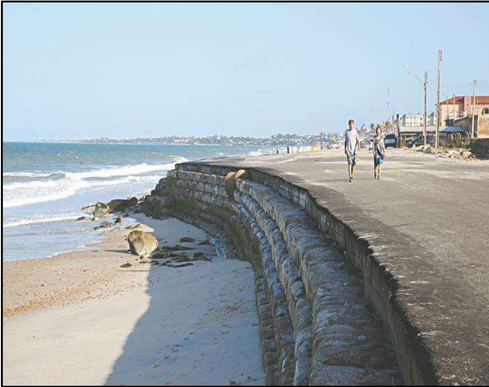
Figura 26. Estrutura de bagwall implantada na praia do Icaraí, no município de Fortaleza - CE. Fonte: ( https://diariodonordeste.verdesmares.com.br/metro/avanco-do-mar-volta-a-preocupar-no-icarai-1.1870623 ).
