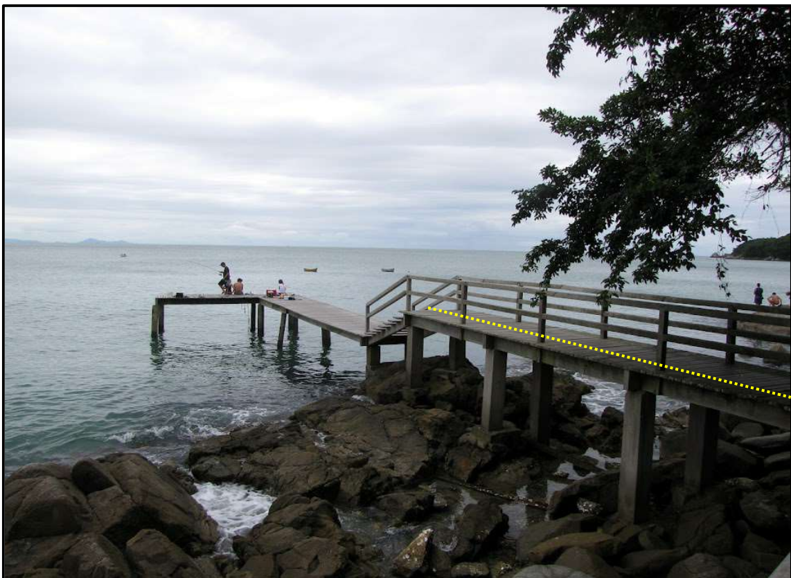
Vista para norte do píer (estrutura #53) (trapiche) implantado na praia da Galheta, no município de Porto Belo, litoral Centro-norte de Santa Catarina. Fonte: (Sílvio César Montibellier).
