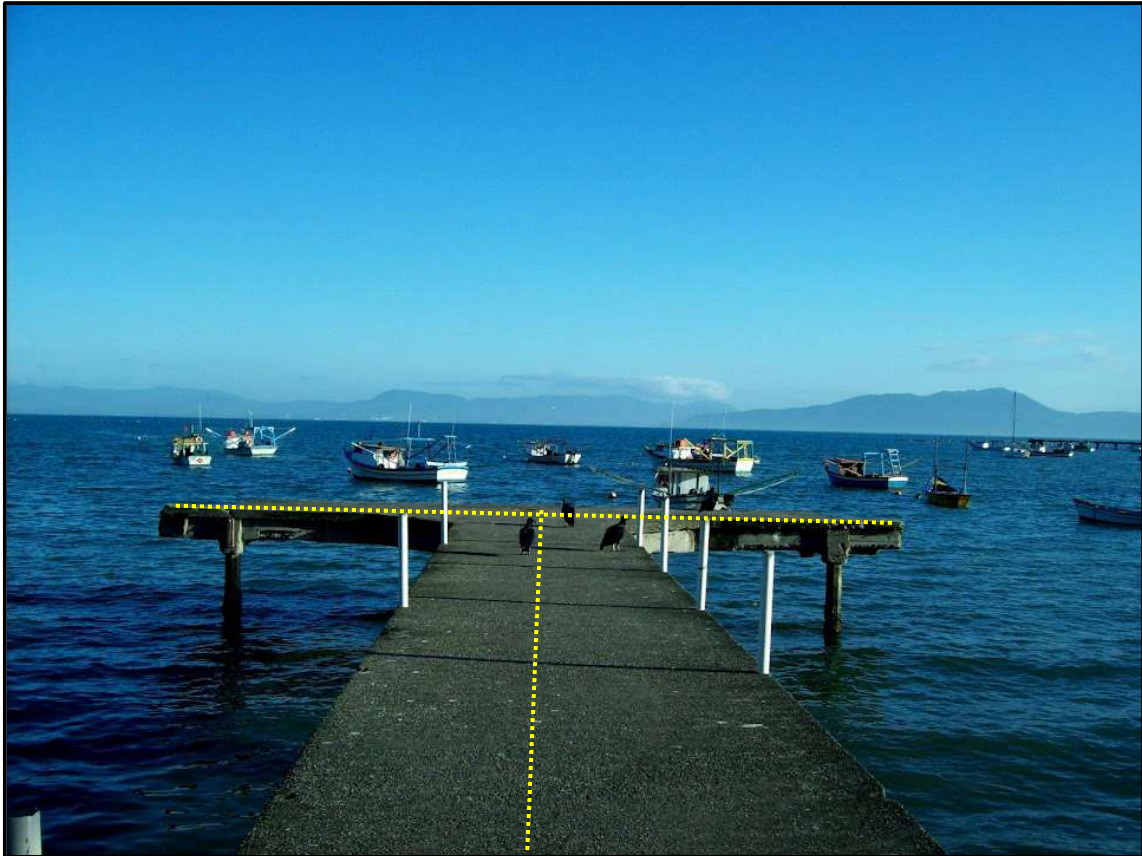
Vista para noroeste do píer (estrutura #39) (trapiche de Ganchos) implantado no Ganchos do Meio, no município de Governador Celso Ramos, litoral Central de Santa Catarina.
