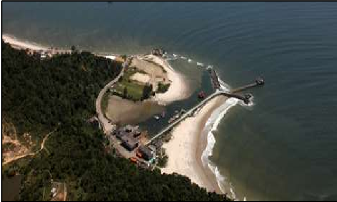
Figura 104. Vista do molhe (#121) implantado entre as praias da Saudade e Enseada, no município de São Francisco do Sul.
