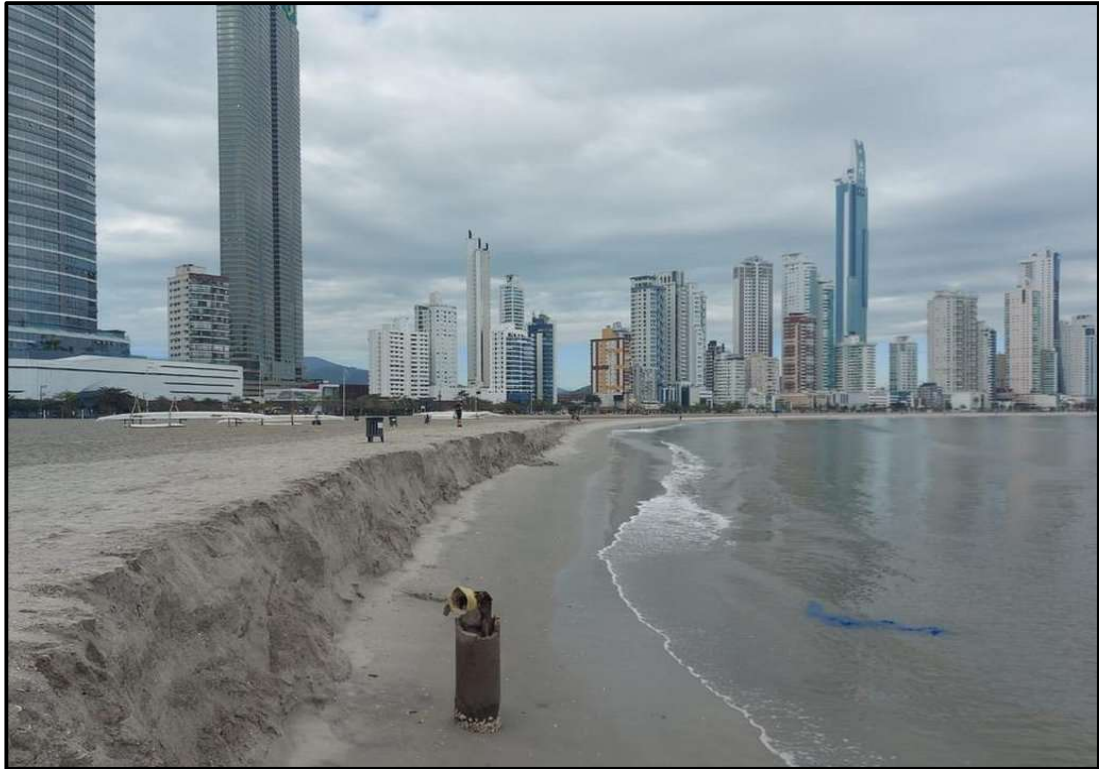
Figura 86. Vista para norte do declive formado na praia de Balneário Camboriú Central, após o engordamento artificial de sedimentos.
