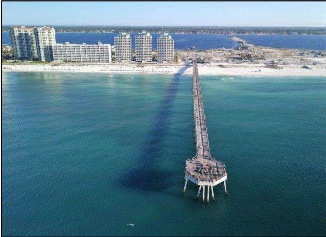
Figura 27. Estrutura de pier implantado na praia de Navarre na Flórida - EUA. Fonte: ( https://www.gazetanews.com/praiacommaiorpierdafloridaquebra-recordes-deturismo/index.html ).
