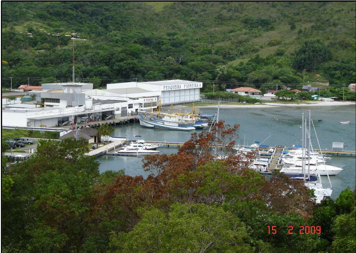
Vista para sudeste da doca (estrutura #65) (late Clube de Porto Belo) implantada na praia do Araçá/Saco, no município de Porto Belo, litoral Centro-norte de Santa Catarina.
