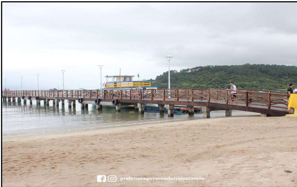
Figura 76. Vista do píer (#33) implantado na praia da Fazenda da Armação, no município de Governador Celso Ramos.
