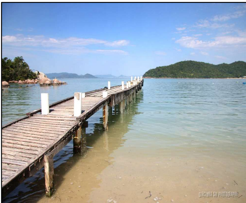
Figura 74. Vista do píer (#27) implantado na praia da Baía dos Golfinhos, no município de Governador Celso Ramos.
