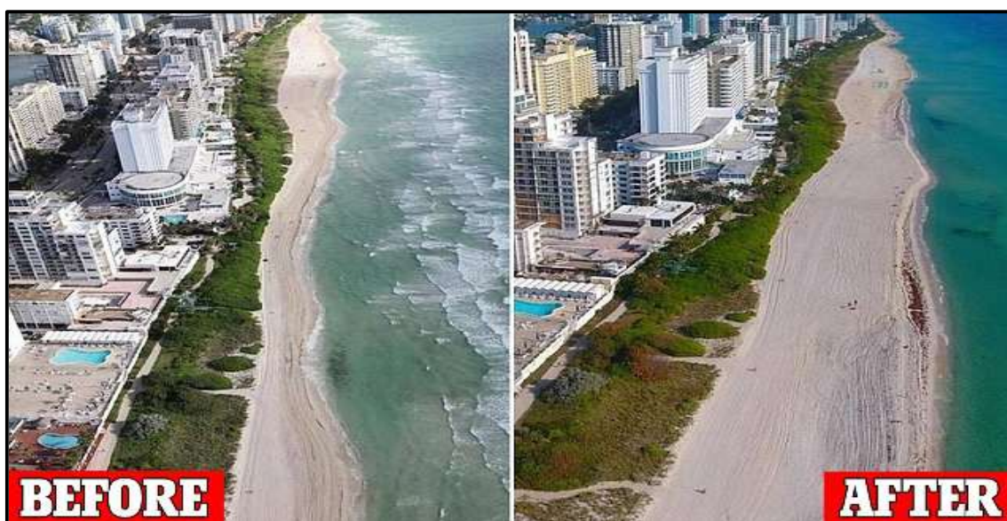
Figura 25. Estrutura de engordamento de praia com alimentação artificial de sedimentos (antes e depois) na praia de Miami - Florida, USA.
