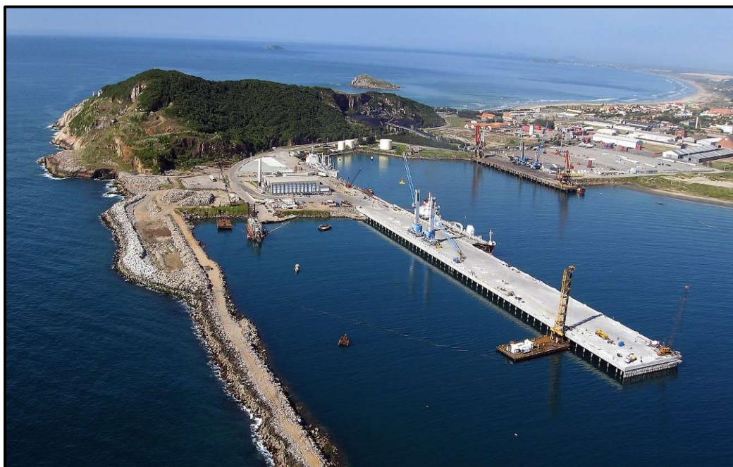
Figura 60. Estrutura tecnogênica do tipo enrocamento na praia do Porto Sul no município de Imbituba, observando-se entre o enrocamento e a planície costeira, uma plataforma suspensa de concreto para atracadouro dos meios flutuantes.
