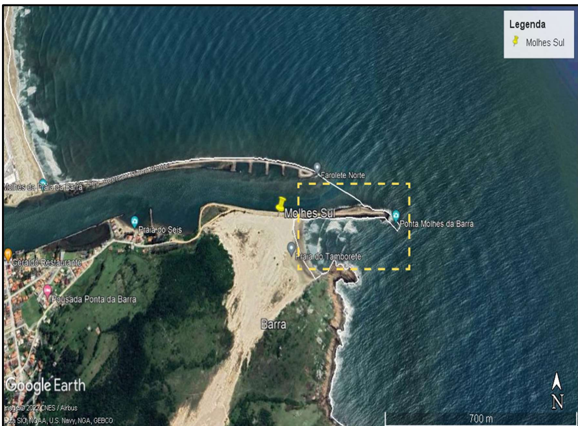
Figura 54. Estrutura tecnogênica do tipo molhe (#8) na Prainha no município de Laguna (linha tracejada em cor amarela). Fonte: Google Earth, 22/01/2019.
