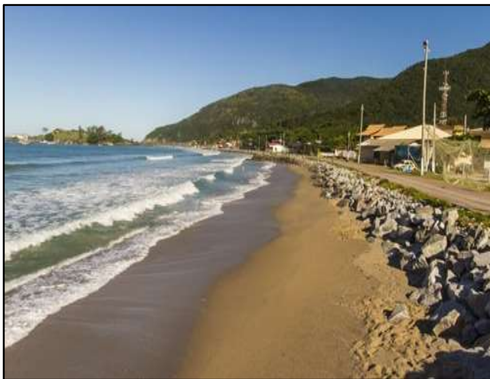
Figura 65. Vista do enrocamento (#18) localizado na praia da Armação, no município de Florianópolis.
