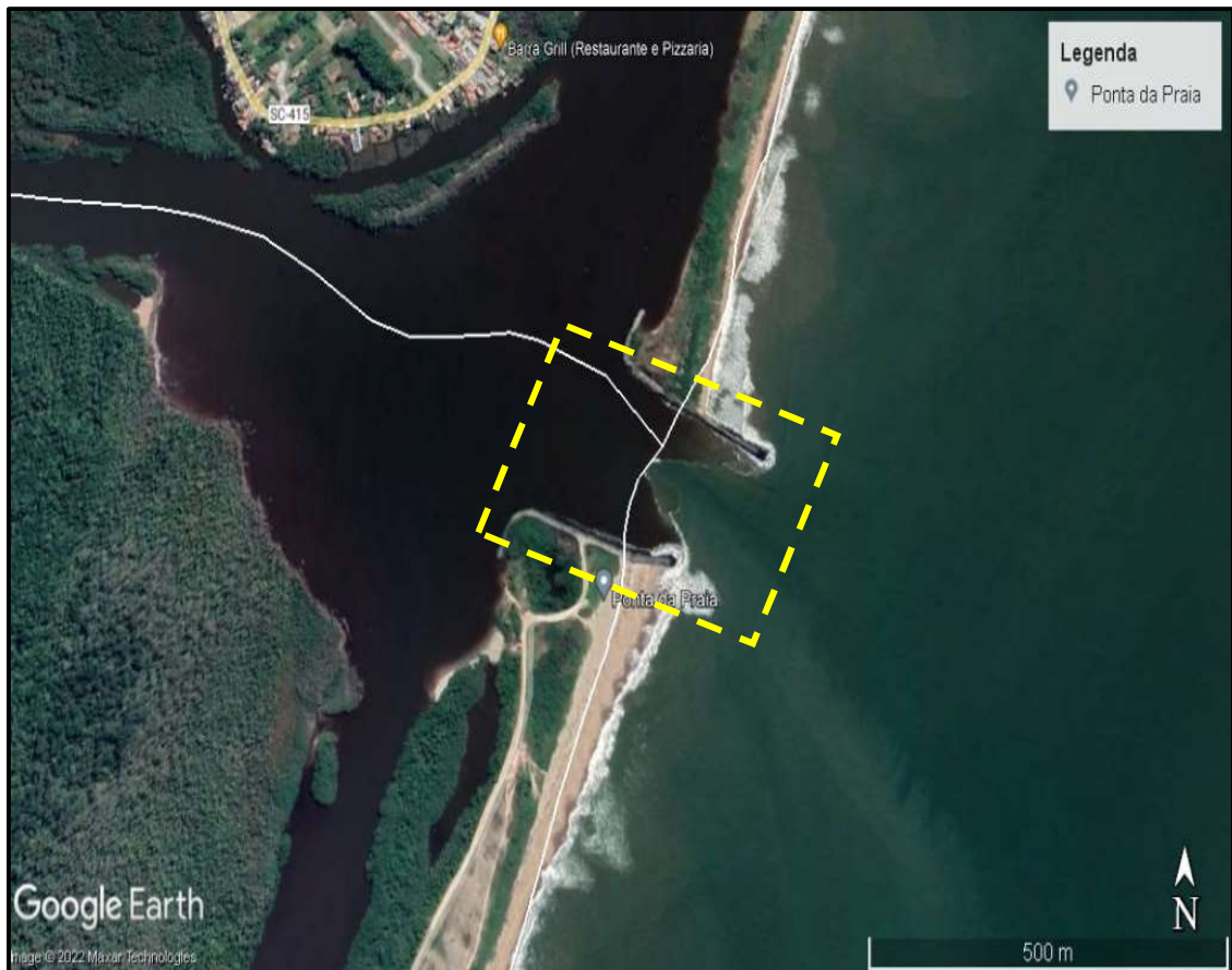
Figura 99. Estrutura tecnogênica molhe (#114) (linha tracejada em cor amarela) implantado na praia de Barra Velha Norte, no município de Barra Velha. Fonte: Google Earth, 10/07/2021.
