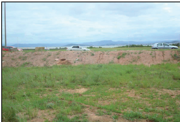
Foto 17. Vista para oeste da Via Expressa Sul demonstrando a interferência antrópica com a acumulação do Depósito Tecnogênico (Foto de Norberto Olmiro Horn Filho, setembro de 2009).
