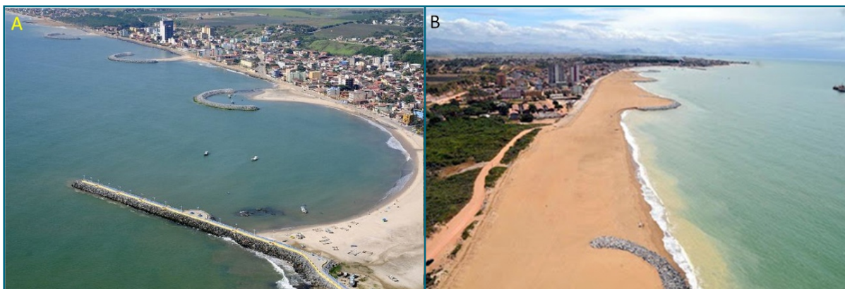
Figura 4. Estruturas de engenharia rígida na Praia Central.
